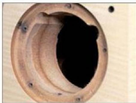
Przednia ścianka jest bardzo gruba – jak widać na zdjęciu – i osiąga przy głośniku wysokotonowym 5 cm
